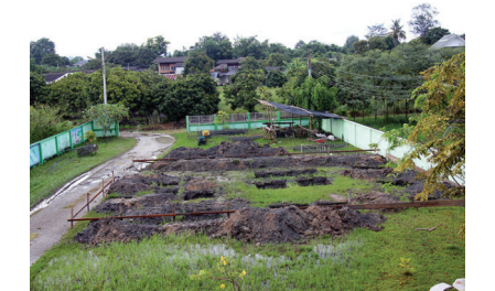
Das Grundstück beim Vorbereiten der Fundamente
